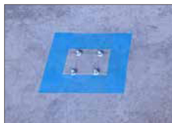
6 アンカーボルト打設
