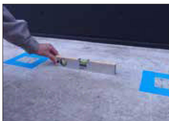
1 設置場所勾配確認
