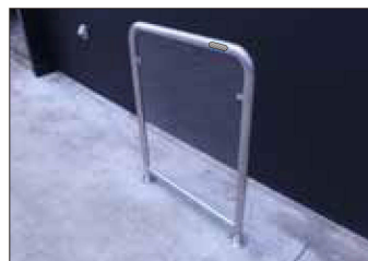
12 保護フィルムを剥がして設置完了
