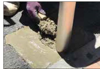
12 モルタル埋設
