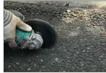
3 床掘り(電動コンクリートカッター)
