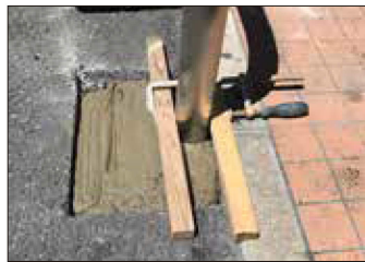
11 養生 ※モルタルが固まるまで
